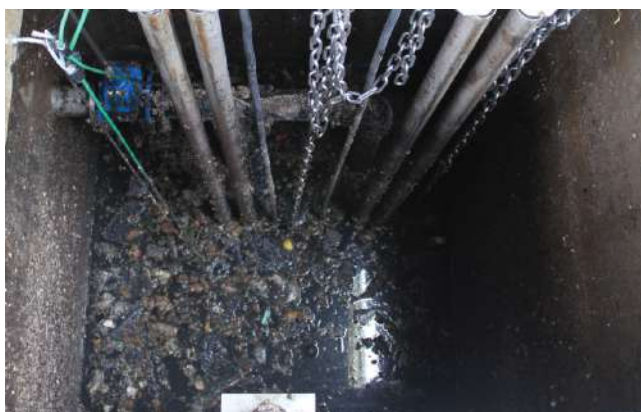
Слева — отстойный резервуар на одной из наших испытательных площадок до монтажа системы Flygt Concertor™. Справа — этот же резервуар через две недели эксплуатации.
