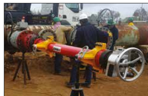
▲ Работы по выполнению горячей резки с помощью СНТ3000 для установки нефтехимического трубопровода.
