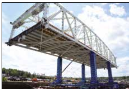
Ступенчатый подъем секций мостов
