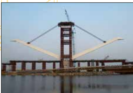
Высокоточный подъем тяжелых конструкций с использованием домкратов
