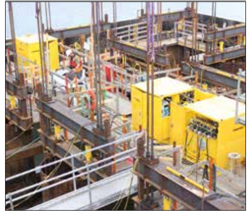
▲ Заказной гидравлический насос для системы надвигки мостов.
