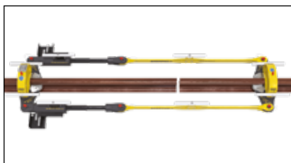
▲ Модульный натяжитель с усилием 70 тонн в процессе сварки удерживает рельсы без изменения их длины.
